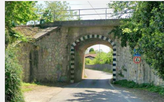
Via Ca' Brusà (sostituzione sottopasso)
