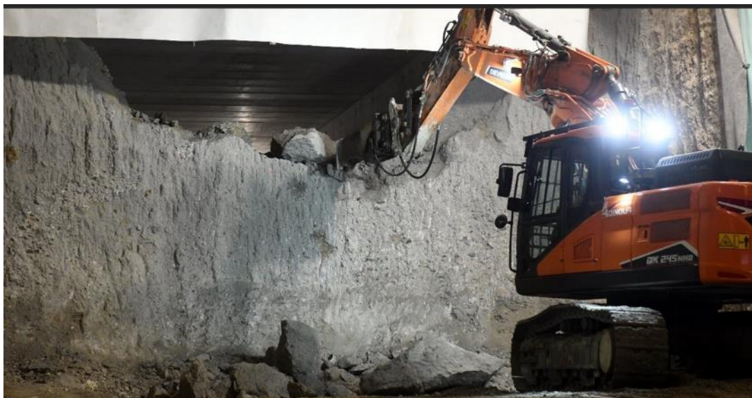
Scavo ultimo diaframma galleria artificiale GA01 a San Martino Buon Albergo (linea AV VR-VI) L=2km
