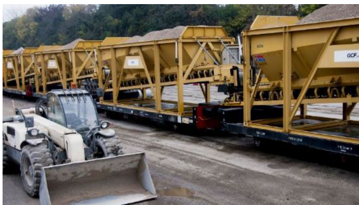
Cantiere di armamento
